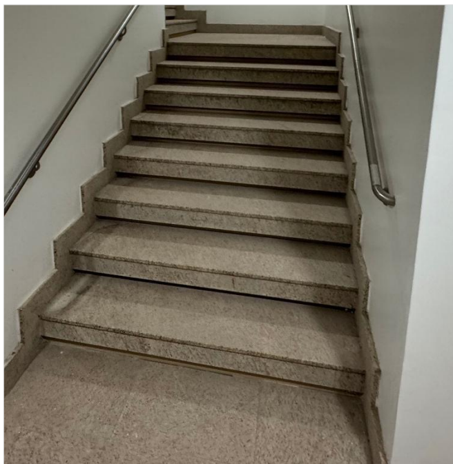
Figura 7 - Piso existente na caixa de escada, utilizado como referência para a recomposição do piso nas áreas afetadas pela intervenção
