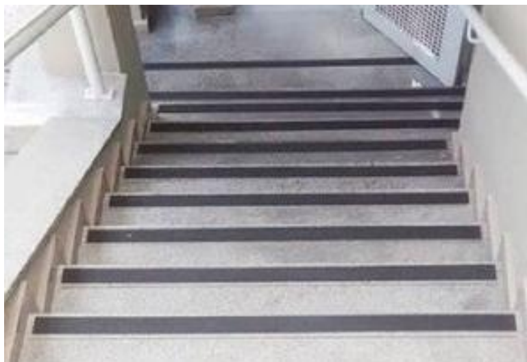
Figura 8 - Exemplo ilustrativo de aplicação de fitas antiderrapantes, uma das soluções previstas para a adequação do piso na área de intervenção.
