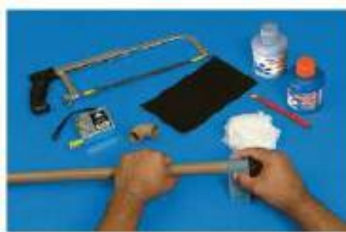
FIGURA 3 - EXECUÇÃO DE JUNTA SOLDÁVEL
