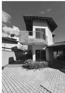
Fachada do Escritório
